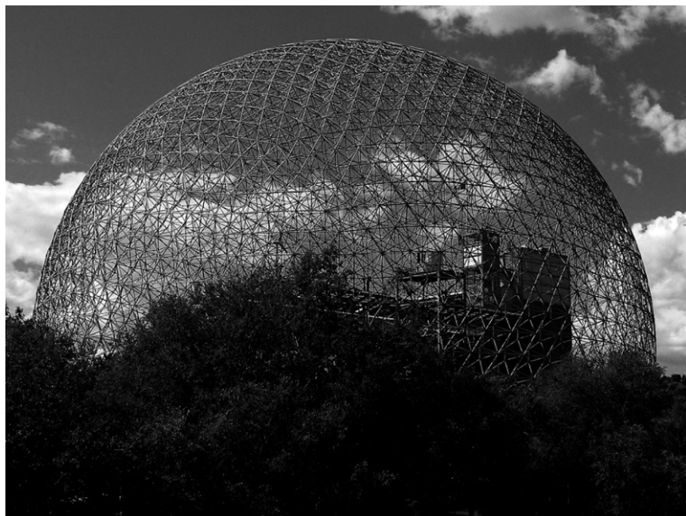
Obr. 7: GEOMETRIE GEODETICKÉ KUPOLE. BIOSFÉRA, MONTREAL. AUTOR BUCKMINSTER FULLER (zdroj Wikimedia Commons)
