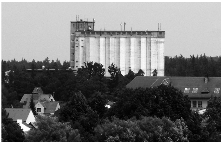
Obr. 6: OBILNÍ SILO JAKO PŘÍKLAD STAVBY BEZ NÁROKŮ NA CITOVÉ PŮSOBNÍ DÍLA.
